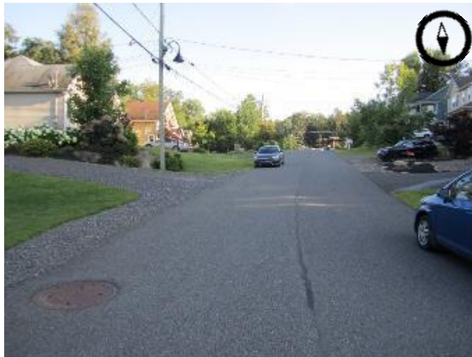
Photo 7 : Vue d'ensemble de la rue en amont
