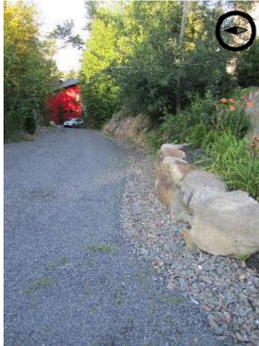
Photo 8 : Drains dans l’allée de stationnement
